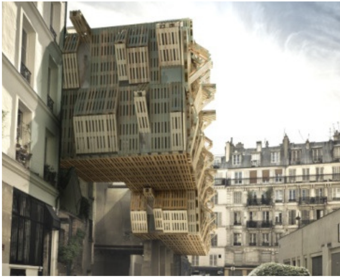
Stephane Malka (1975 - ), AME-LOT , 2011, recouvrement extérieur constitué de modules en palette de bois reliés par des charnières horizontales, Paris, France.
