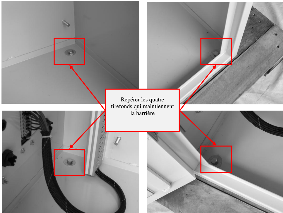
Figure 2 Repérage des tirefonds
