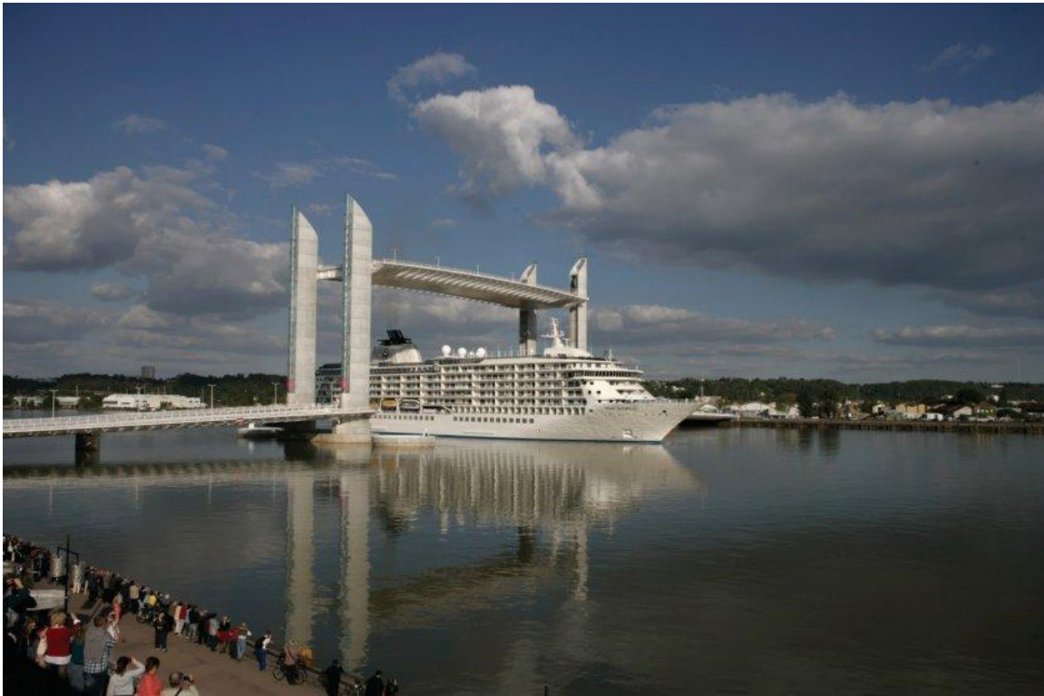
Pont Chaban Delmas Bernard LAMARQUE
