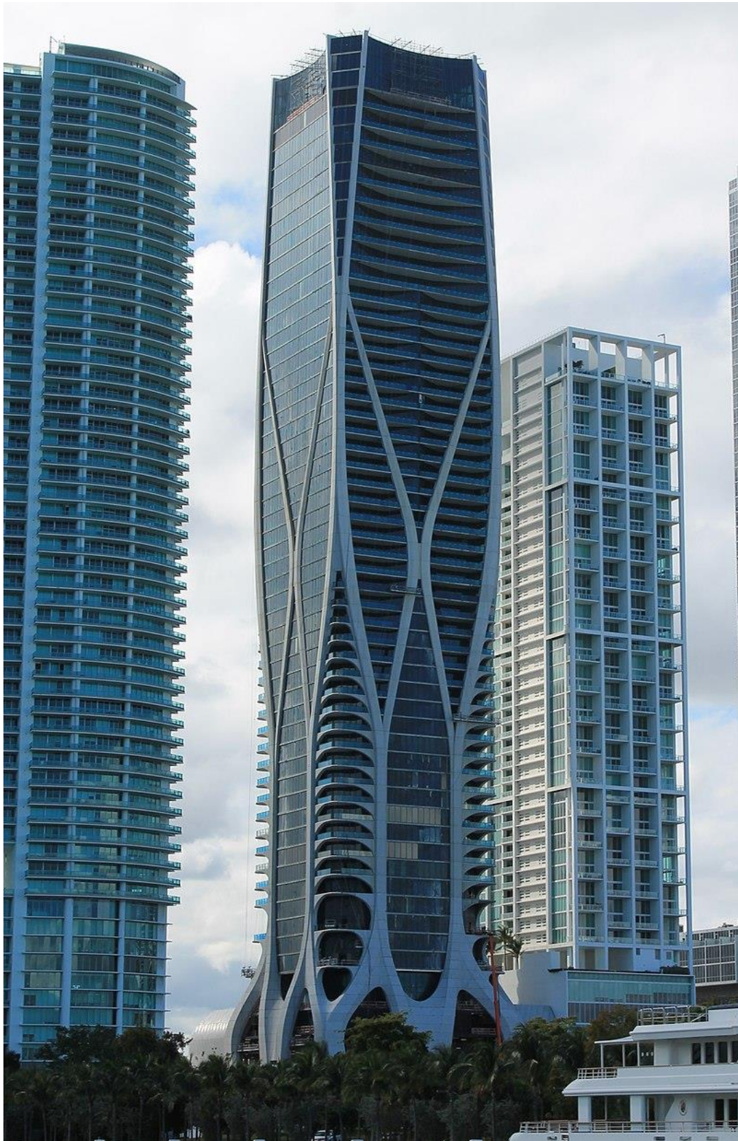
Par Godsfriendchuck — Travail personnel, CC BY-SA 4.0, https://commons.wikimedia.org/w/index.php?curid=77750731 Miami : One Thousand Museum, gratte-ciel résidentiel livré en 2018, de style ultra-design-organique haut de 215 m (62 étages) est un des ultimes projets de la célèbre architecte Zaha Hadid (1950-2016).
