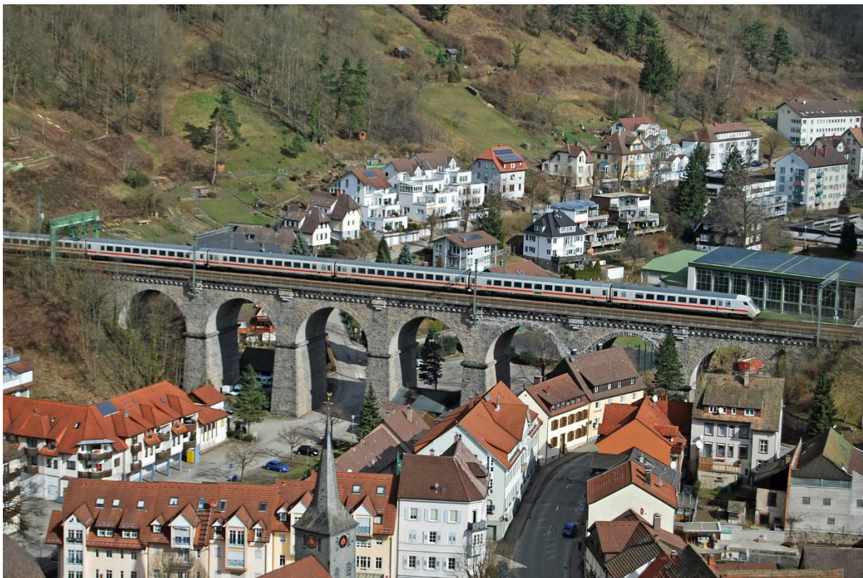
Die Schwarzwaldbahn Viadukt der Schwarzwaldbahn in Hornberg
