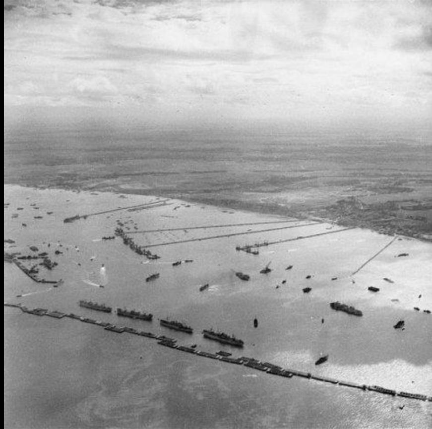
Des caissons de béton de 6000 tonnes chacun sont acheminés pour constituer un brise-lames empêchant les vagues de perturber le débarquement et de constituer un quai: en un mois, 2 millions de soldats, 500 000 véhicules, 1000 locomotives,
