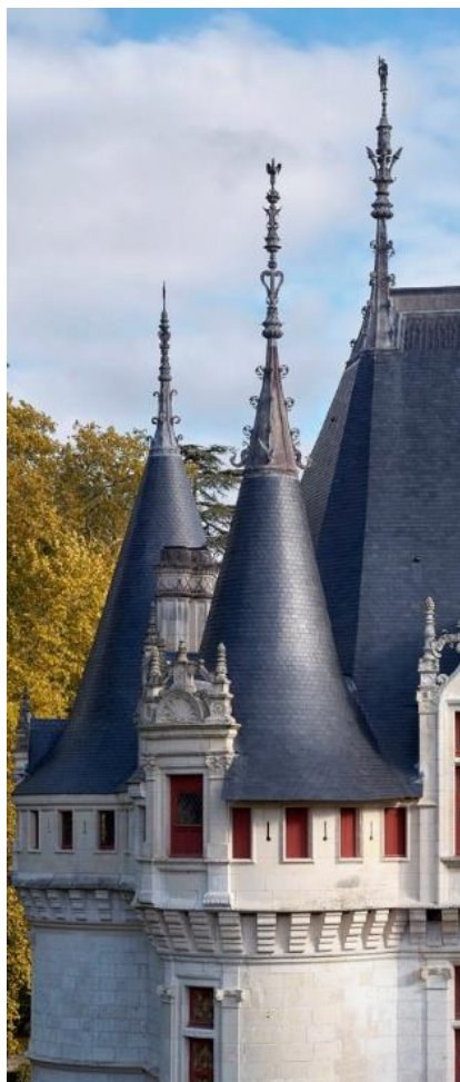
Vue aérienne de la toiture du château d'Azay-le-Rideau © Christian Gluckman / CMN
