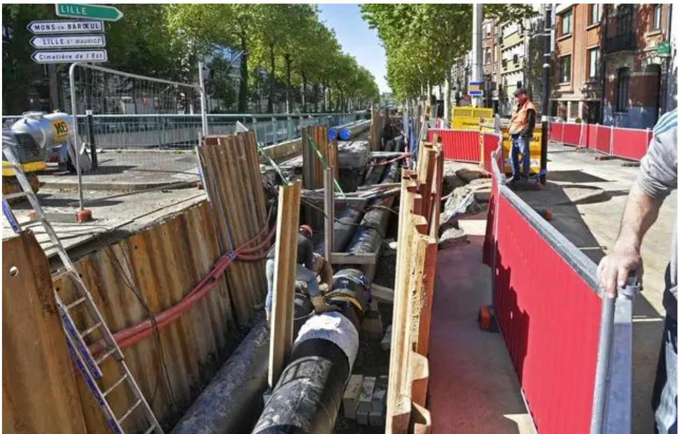
L'autoroute de la chaleur doit passer dans dix communes de la métropole — MEL
