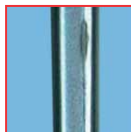
Corrosion de contact : acier inox / laiton
