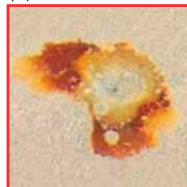
Exemple de corrosion par piqûres
